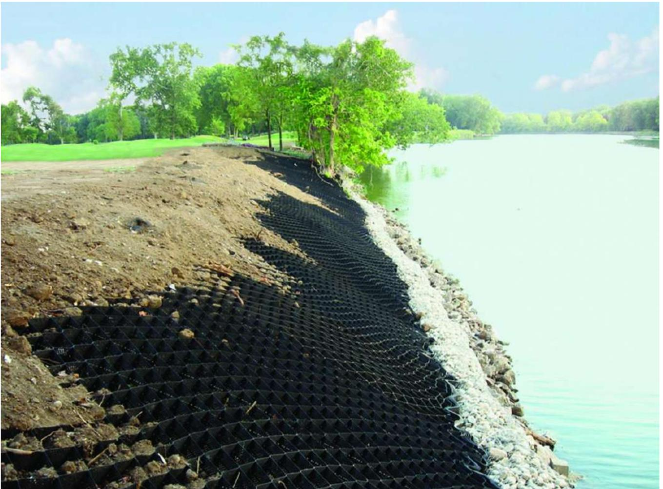
Георешетка - простой и эффективный способ облагородить и укрепить водоем. Это прекрасное решение для получения армированной конструкции в рекордно короткие строительные сроки. Использование георешетки допускается на сравнительно пологих склонах, чья крутизна не превышает 45 градусов. Высота ребра ячейки георешетки зависит от крутизны склона. Если угол не превышает 10-30 градусов, то достаточно 10 см. При крутизне склона до 45 градусов рекомендуемая высота решетки составит 15 см или 20 см.
