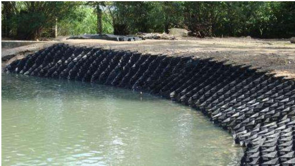
Строительство начинается с зачистки береговой линии от растений, дерна, мусора и других предметов, которые могут мешать при установке и засыпке георешетки. Выровненное основание уплотняется при помощи виброплиты или катка. Далее раскатывается полотно нетканого геотекстиля, которое будет одновременно выполнять армирующую и разделительную функцию (предупреждать просыпание наполнителя).
